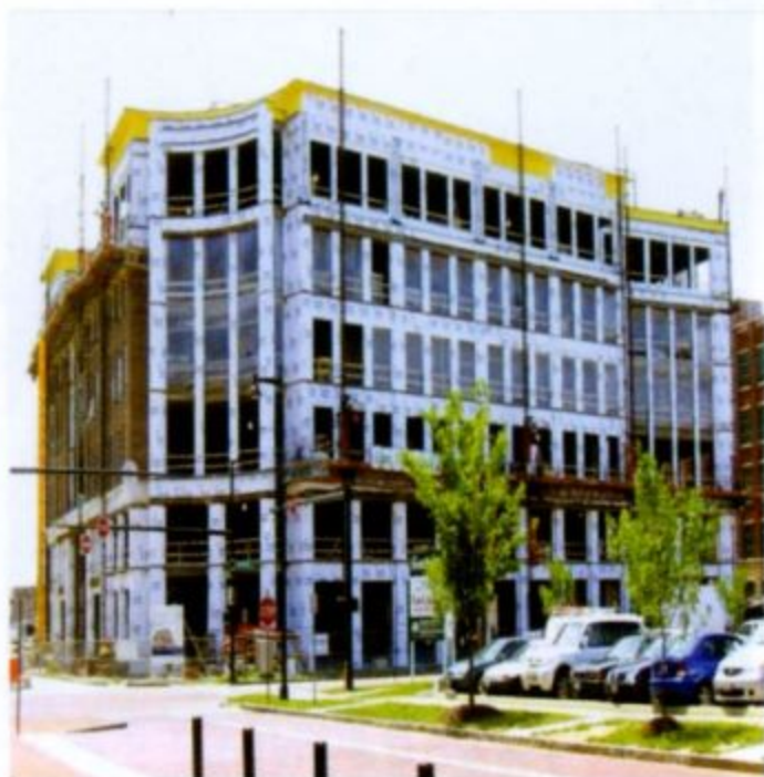
瓷板幕墙保温层外覆防风防水透汽膜
