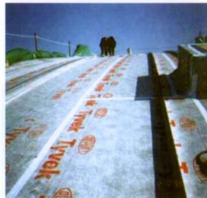
大跨度弓形屋面保温层 上(外)覆防风防水透汽膜透汽膜
