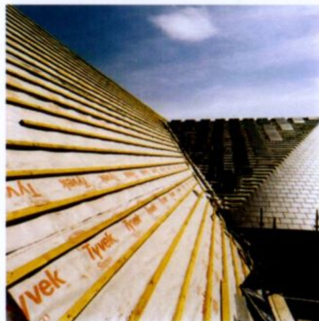
大坡度屋面保温层 上(外)覆防风防水透汽膜
